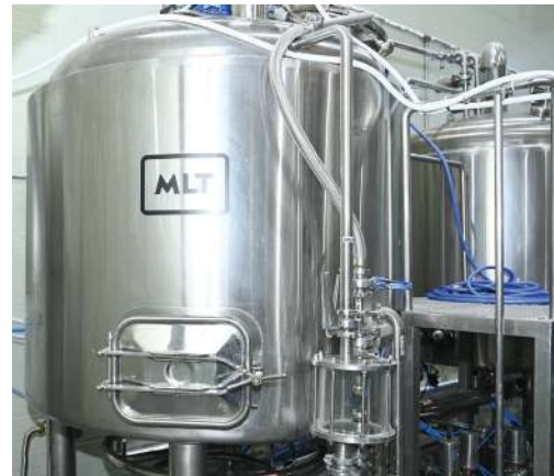
와일드웨이브 양조장의 스테인리스 발효조 설비
