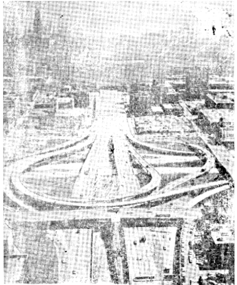
기성도시의 입체교차로의 한 예, 물론 여기에는 고스톱의 신호는 필요치 않다. 왼편 윗측의 뾰족한 마천루의 스타일이 입체도로와 어울리지 않는 점이 특색이다.
