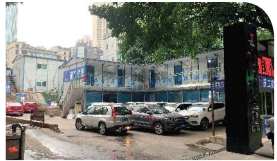
대한민국임시정부 오사야항 청사 터 2013년 철거된 오사야항 청사 터에는 현재 공사장 주차장이 들어서 있다. 철거 전에는 ‘대한민국임시정부 구지’라고 표기된 표지석이 있었으나 이마저도 같이 철거되었다.
