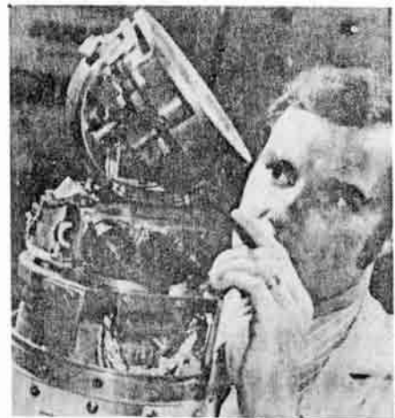
〈AMRAAM의 Active Radar Seeker, 도형의 레이더로서, 성능이 매우 우수함〉
